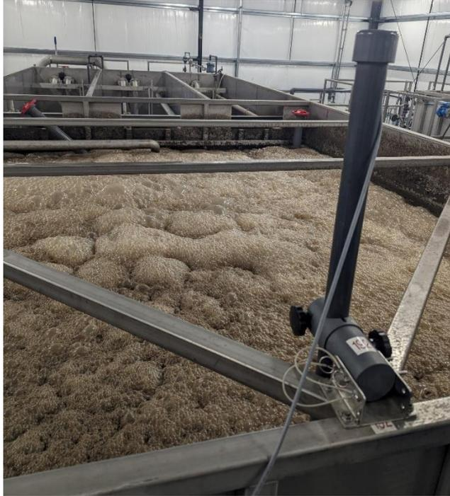
Imagen 3: Tanques de procesamiento MBR dentro de la instalación de tratamiento
